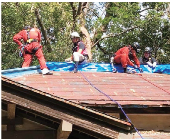
屋根のブルーシート張り
